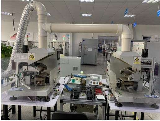
焊接废气集气装置
