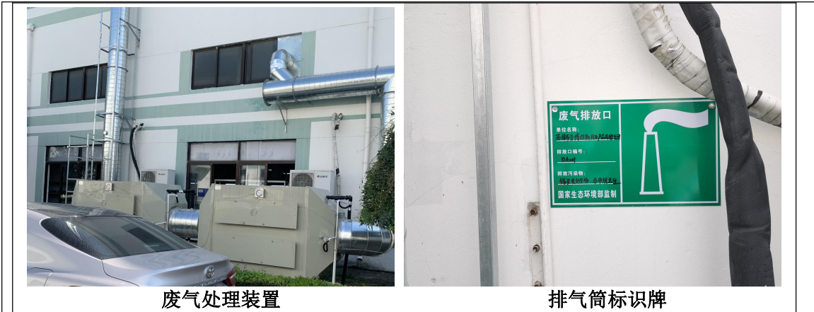
图3-3 废气排气筒
