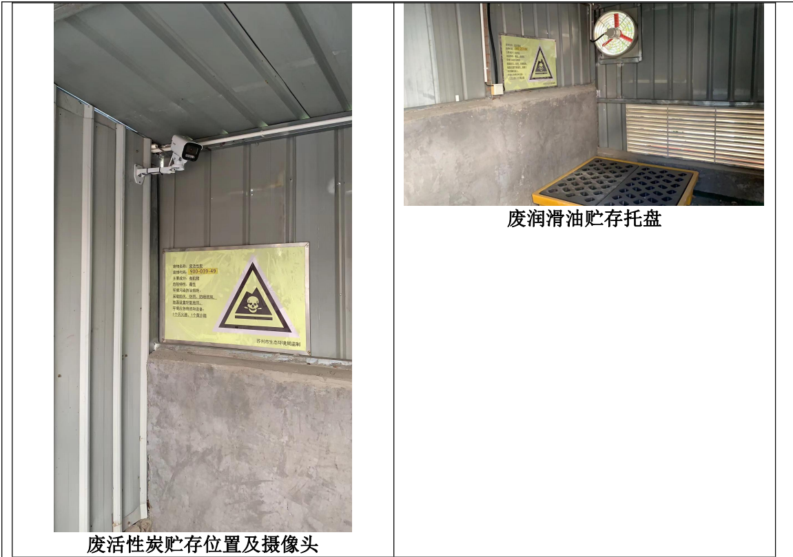
图3-7 危险废物贮存场所建设现状
