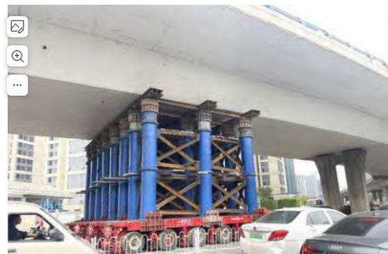
箱梁上部结构拆除示意图
