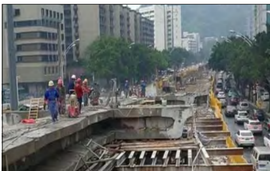
箱梁上部结构拆除示意图
