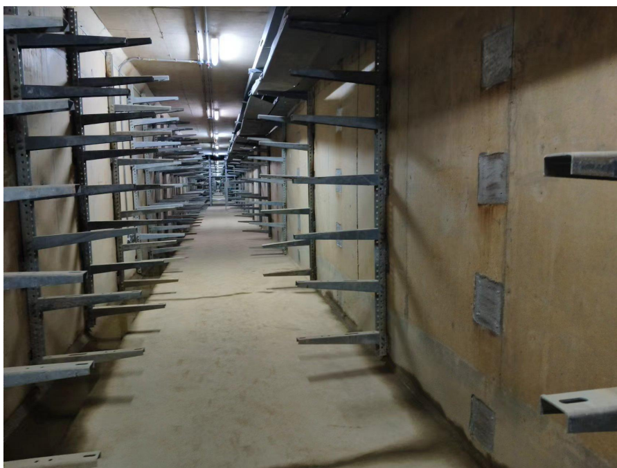
图 4-1 本项目主体工程建设情况
