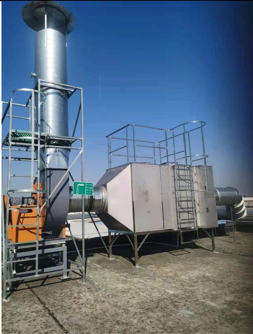
图 3.2-3 废气处理设施及排气筒
