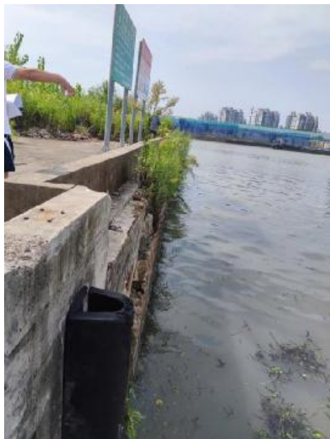
图 2-13 泥店港河口南岸现状护岸照片 1
