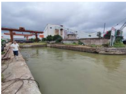
图 2-1 2#港池现状护岸照片
