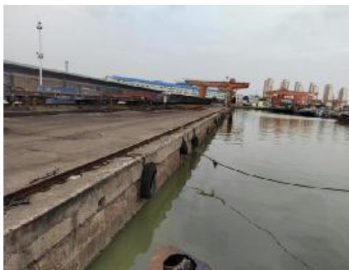
图 2-4 4#港池现状护岸照片 1
