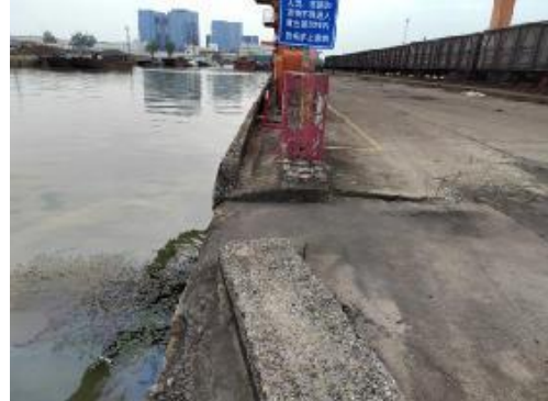
图 2-12 4#港池现状护岸照片 2
