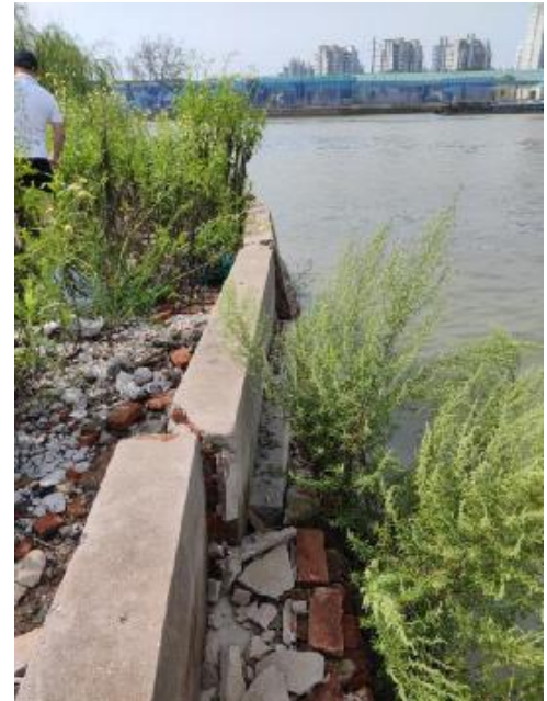
图 2-14 泥店港河口南岸现状护岸照片 2
