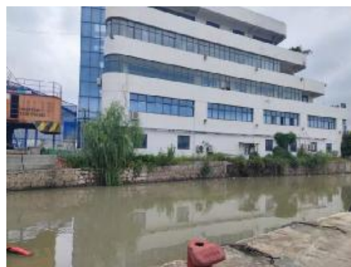
图 2-2 支河北岸现状护岸照片
