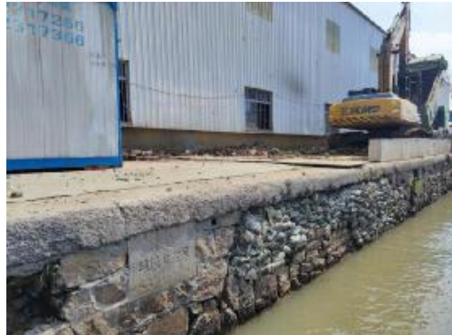
图 2-16 苏州储运现状护岸照片
