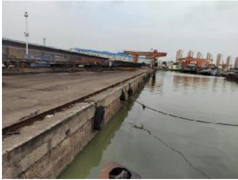
图 2-11 4#港池现状护岸照片 1
