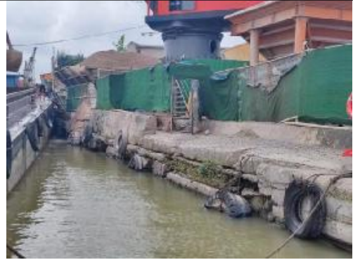
图 2-18 富利峰现状护岸照片
