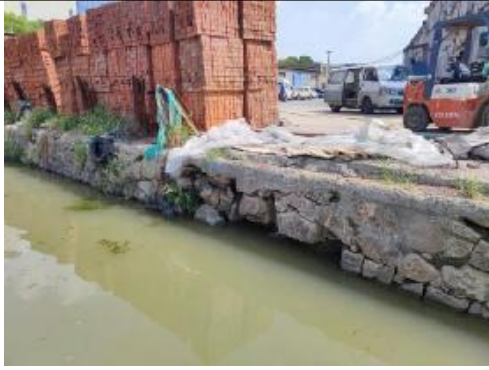
图 2-17 驰顺物流现状护岸照片
