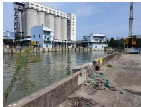
图 2-8 泥店港现状护岸照片 2
