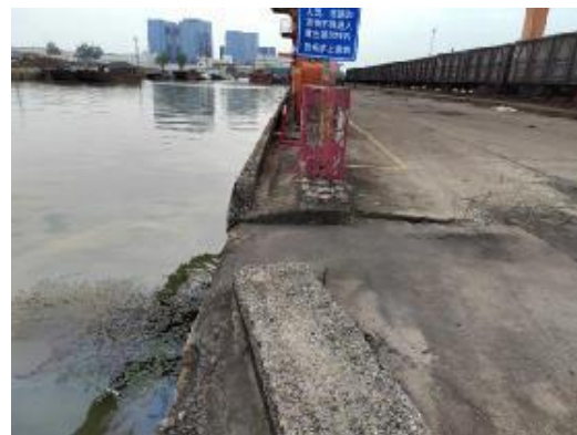
图 2-5 4#港池现状护岸照片 2
