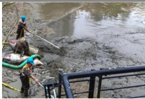
水力冲挖清淤
