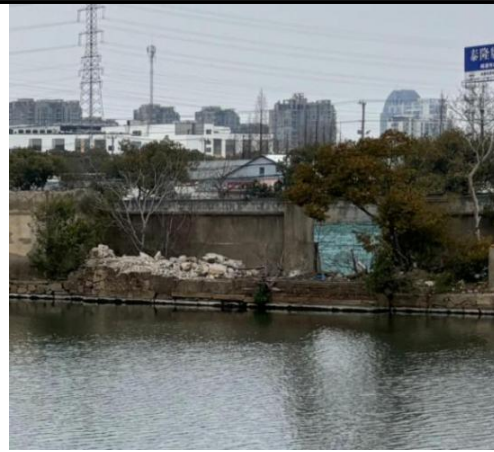
元和塘护岸破损现状
