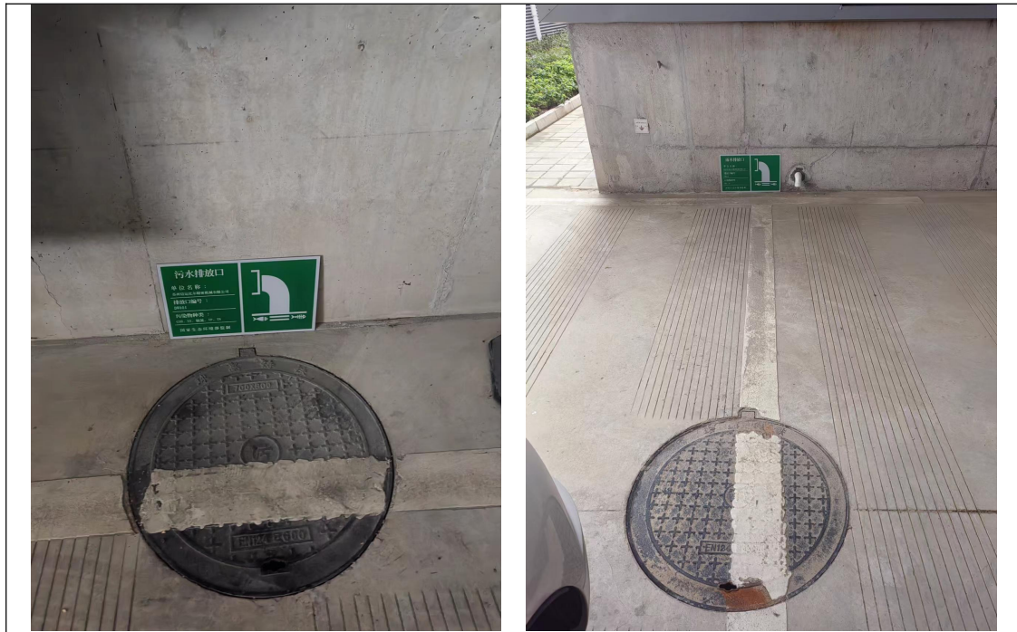
图 3-1 雨污水排口照片
