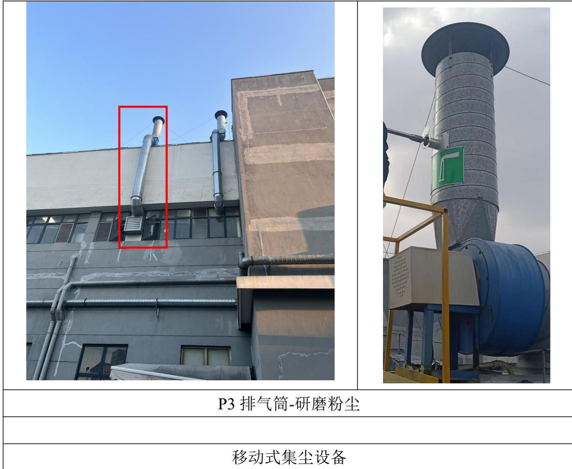
图 3-3 废气处理设施及排气筒
