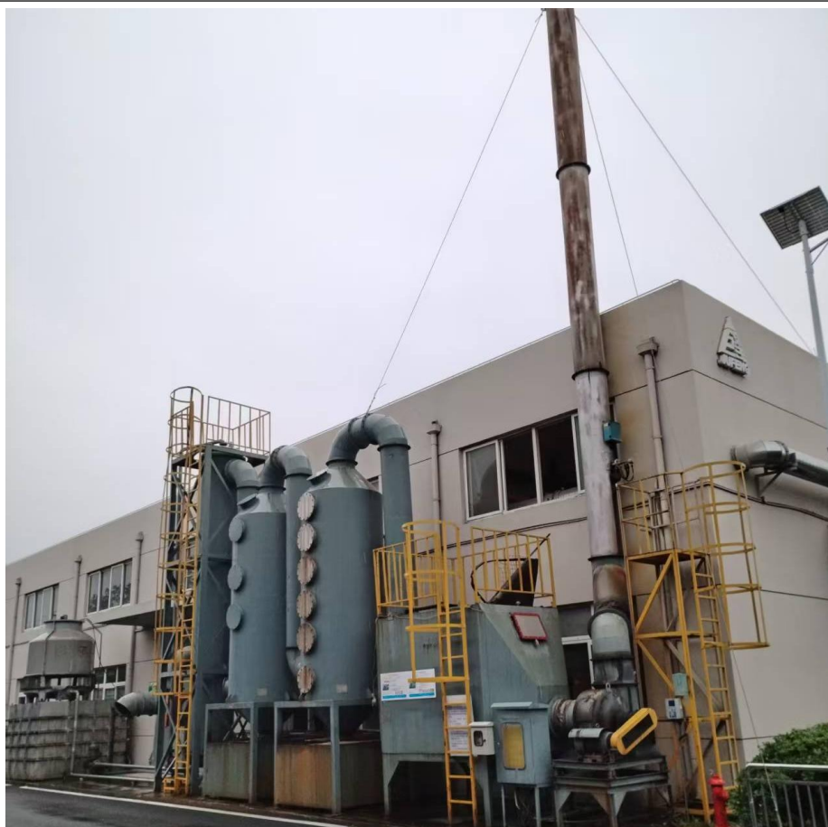
4#冷凝器+二级水洗塔+活性炭吸附装 DA004 (P7) 排气筒
