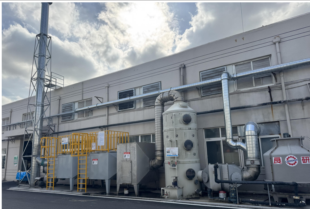
3#换热器+水洗塔+除雾箱+二级活性炭吸附装置 DA006 (P6) 排气筒
