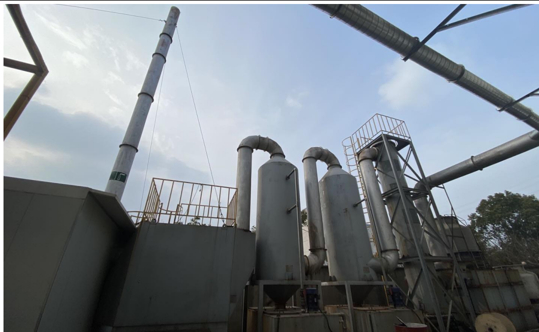
1#换热器+水洗塔+除雾箱+二级活性炭吸附装置 1# DA005 (P1) 排气筒
