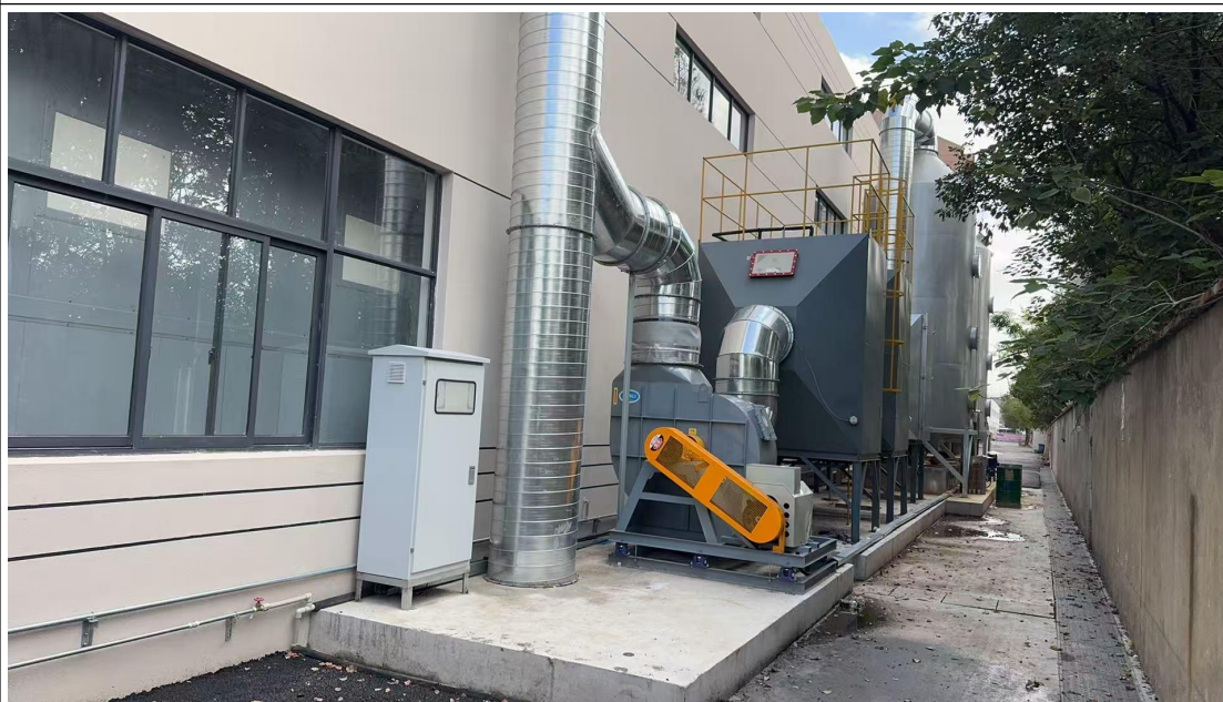
2#换热器+水洗塔+除雾箱+二级活性炭吸附装置 DA007 (P2) 排气筒
