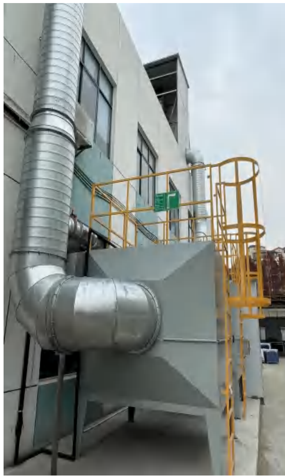
图 3-3 废气处理装置照片
