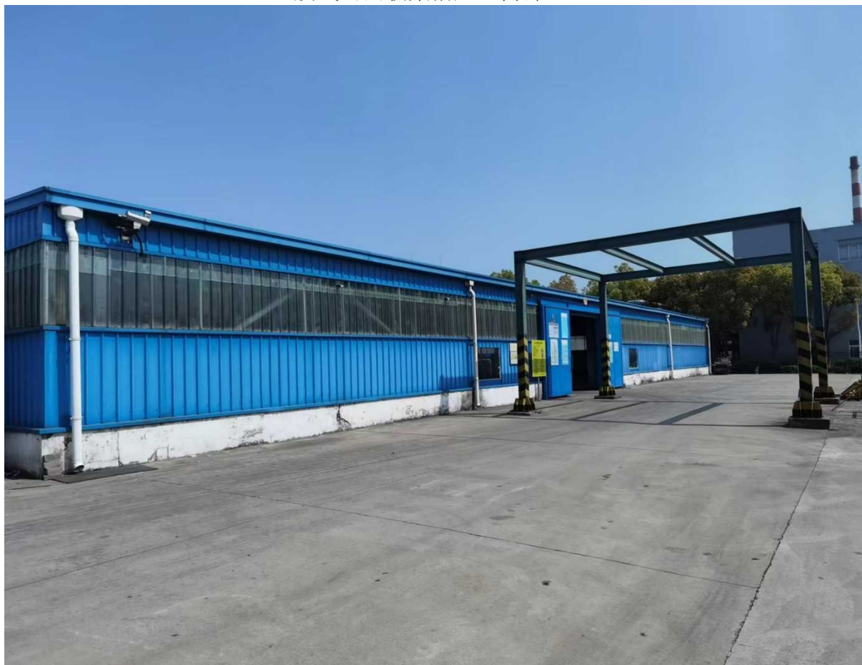
废气密闭收集措施（外观）
