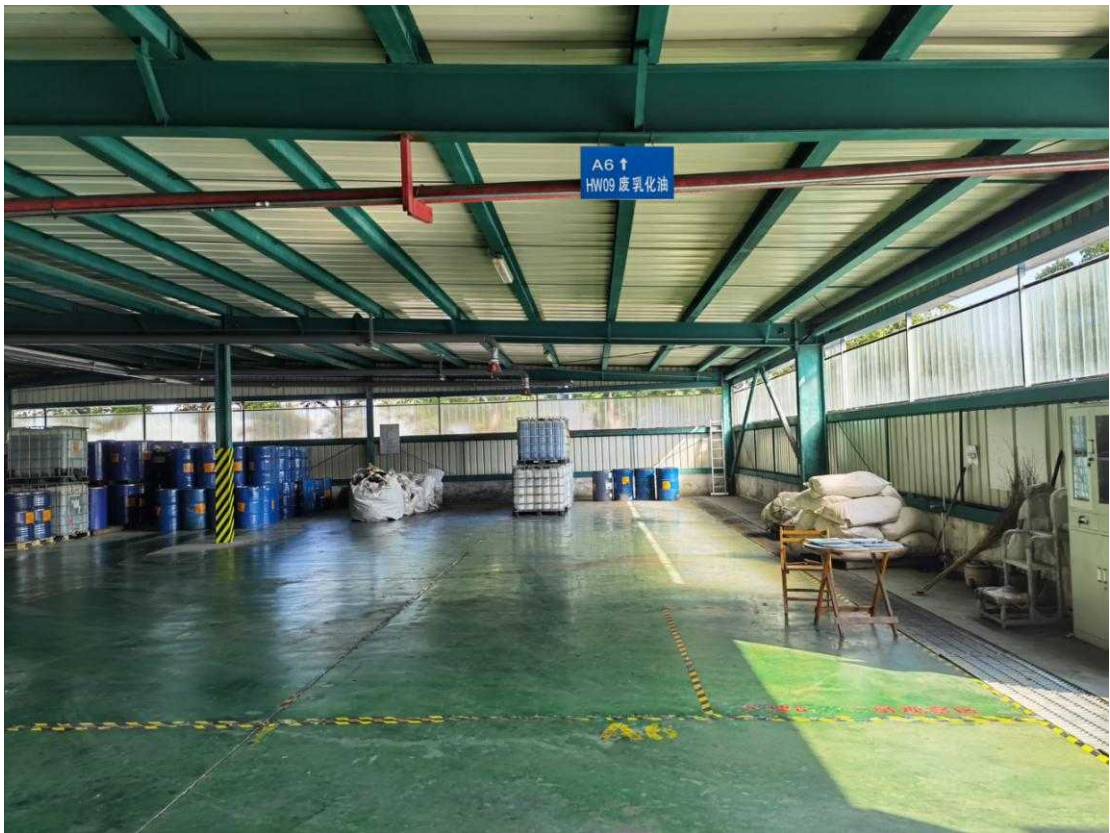
危废仓库分区存放及地面防腐防渗措施
