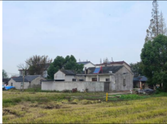
图 3-7 陆巷村东北侧民房
