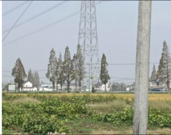
图 3-3 本项目现有塔基处环境现状
