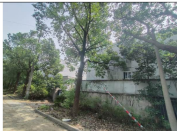
图 1-2 沙洞路和浦发路交叉口西侧厂房
