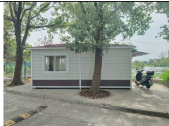
图 1-3 常熟市南湖生活垃圾填埋场门卫室
