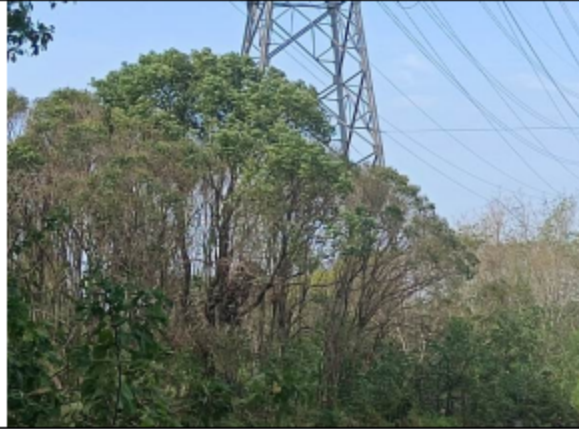
图 3-3 本项目现有塔基处环境现状
