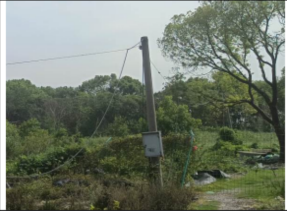
图 3-4 本项目拟建塔基（电缆终端平台）处环境现状
