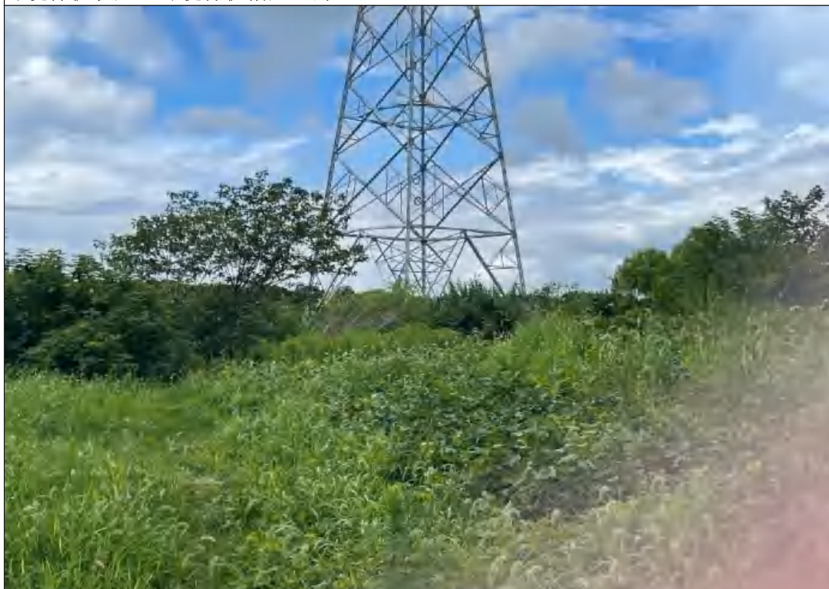
新建架空线路塔基处生态恢复照片
