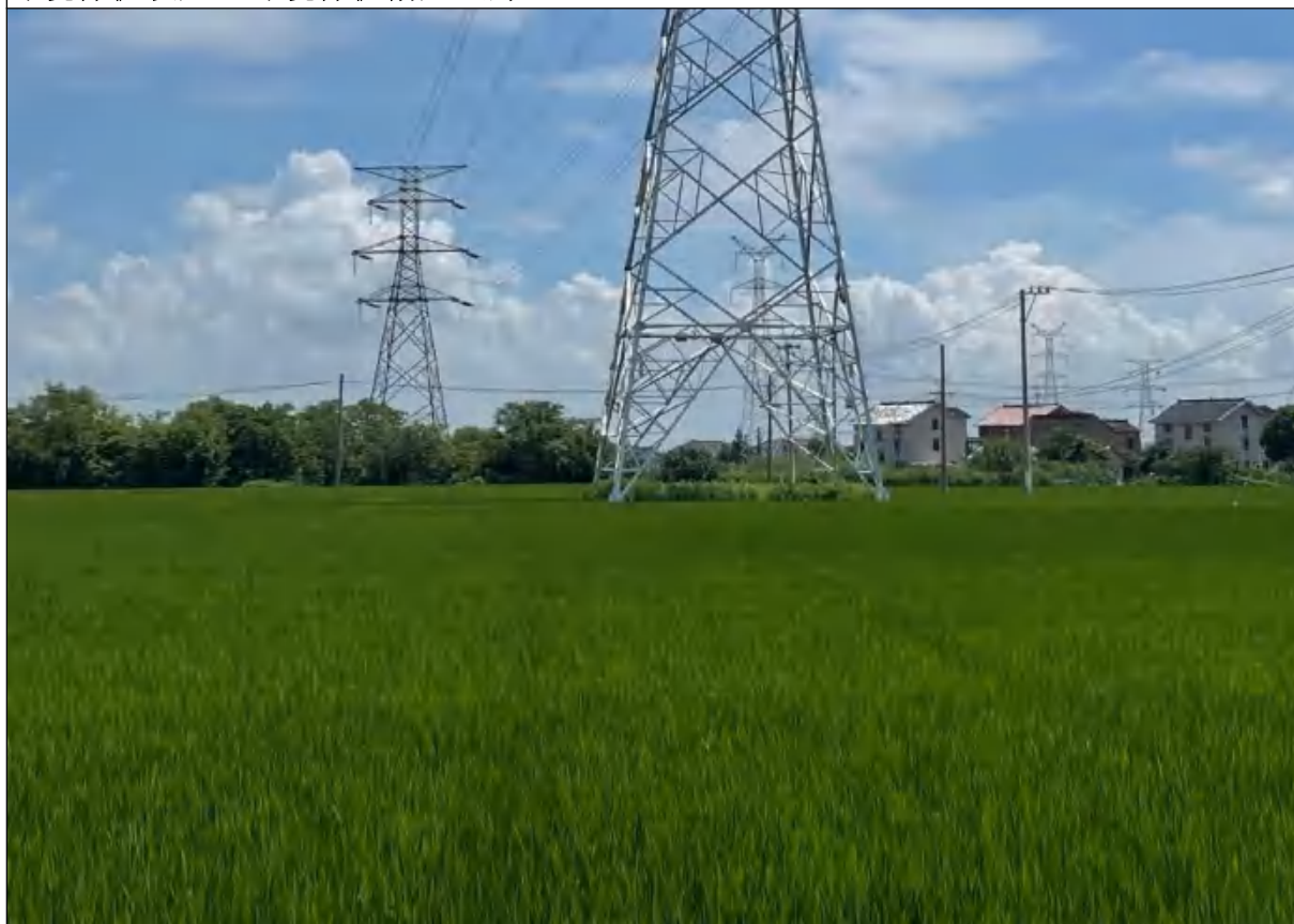
新建架空线路塔基处生态恢复照片
