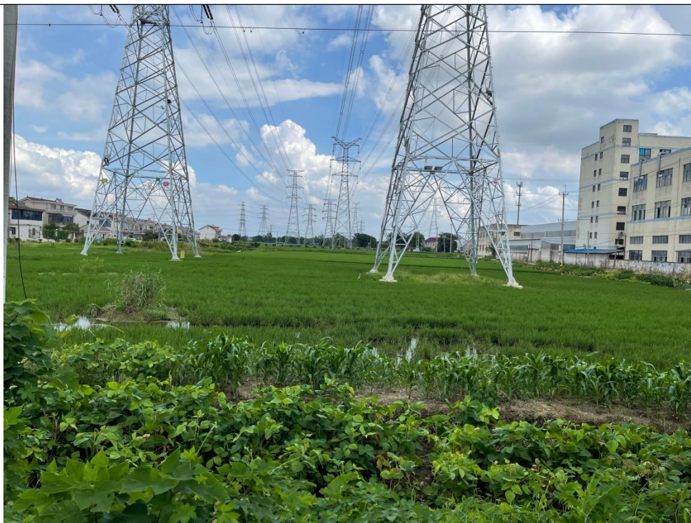
线路沿线生态恢复照片
