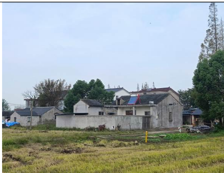
图2-3 陆巷村东北侧民房
