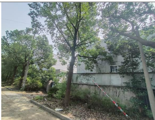
图2-2 沙洞路和浦发路交叉口西侧厂房
