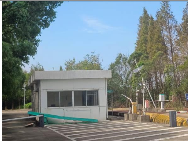
图2-4 常熟浦发热电能源有限公司门卫室
