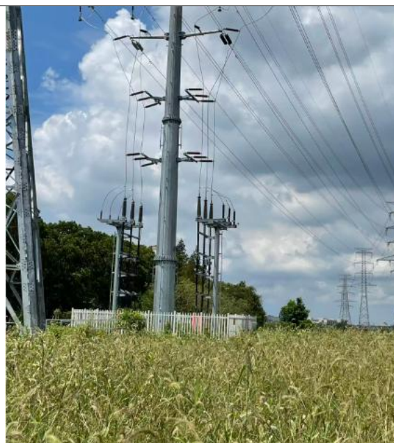
恢复架线段为220/110/35混压四回沿 线生态恢复现状
