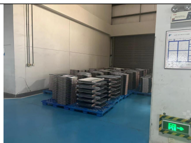
X 射线检测室西侧（空压机房）
