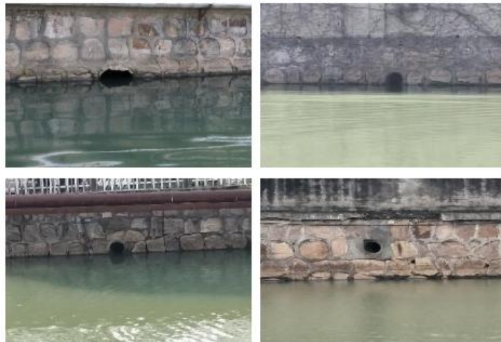
图 3-1 现状河道排口
