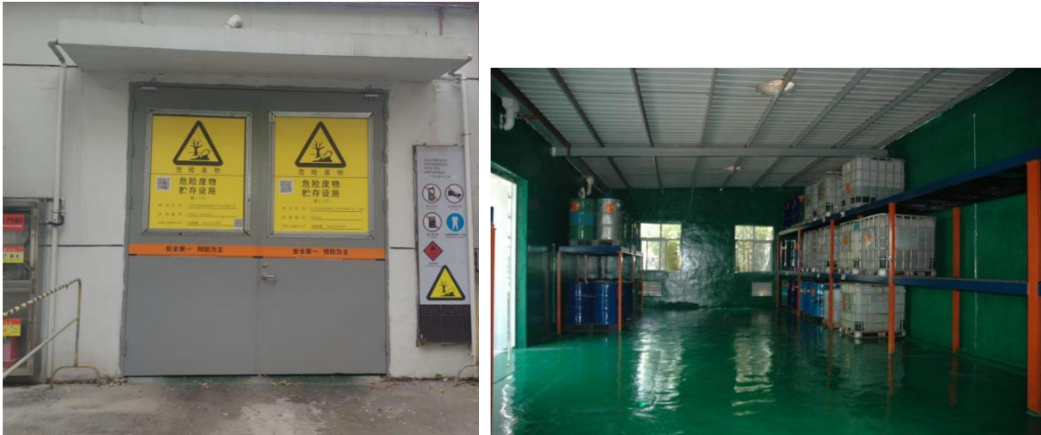
图 3.9-1 原料危废仓库和次生危废仓库图片
