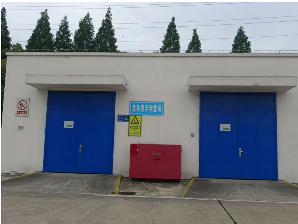
图 3.9-1 现有厂区危险废物暂存场所照片
