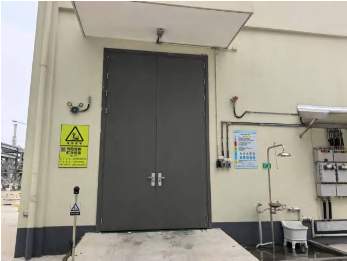
图 4.1-5 本项目危险废物贮存场所照片
