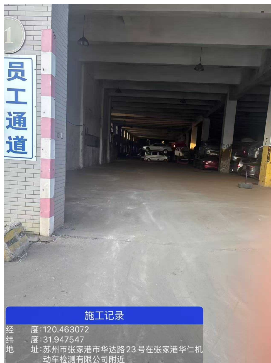
图 3.1.2-1 拟租用厂房外观及内部踏勘图
