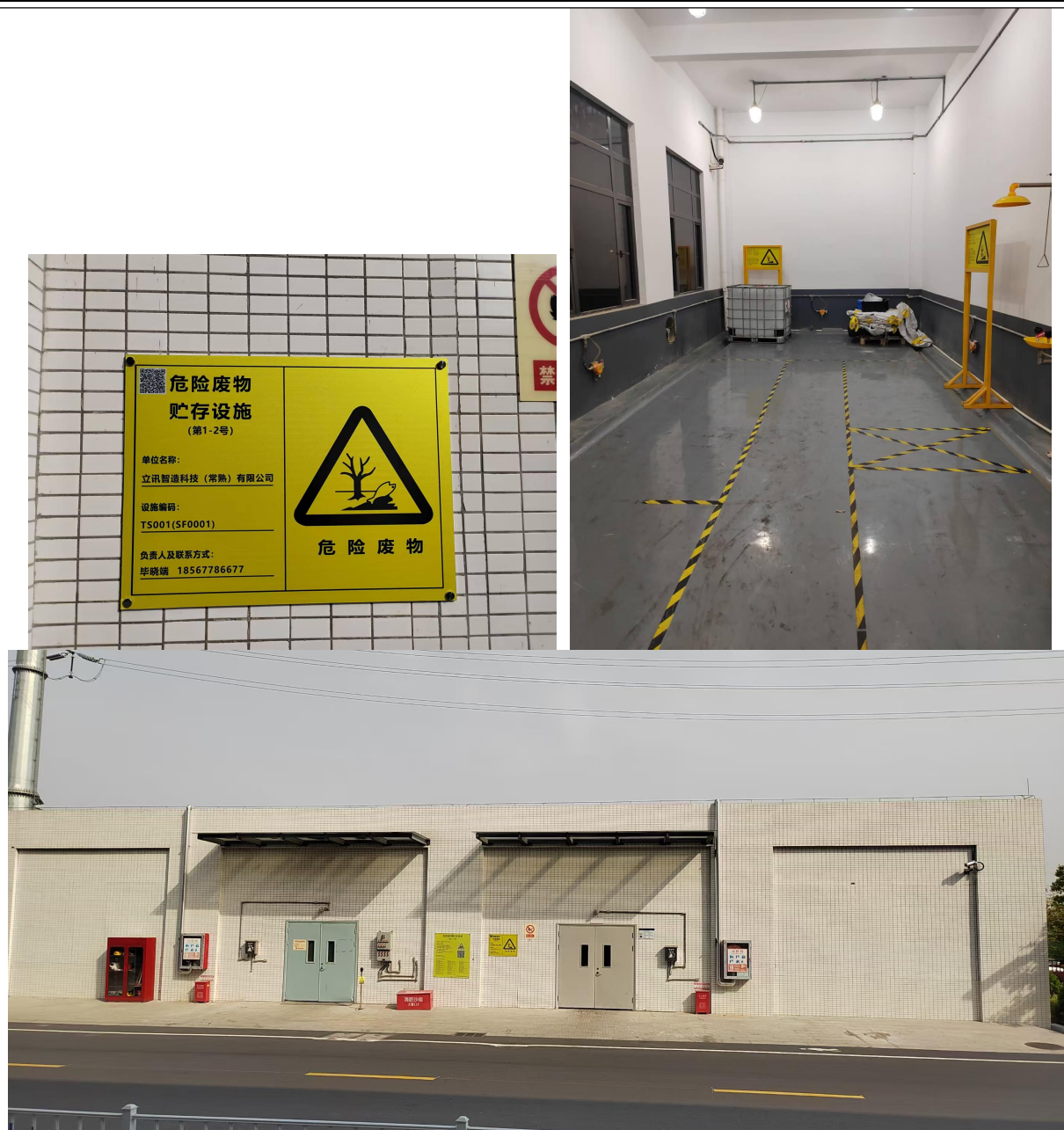
图 3-3 厂区现有 1-2 号危险废物仓库
